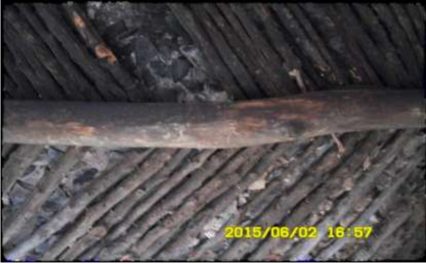
صورة ٠٦ : تسقيف الطابق الأرضي للمسجد (عن الباحثة)
