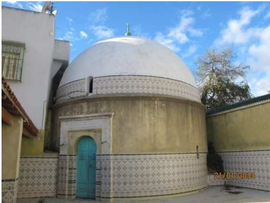
الصورة ٤: منظر خارجي لضريح سيدي السعد
