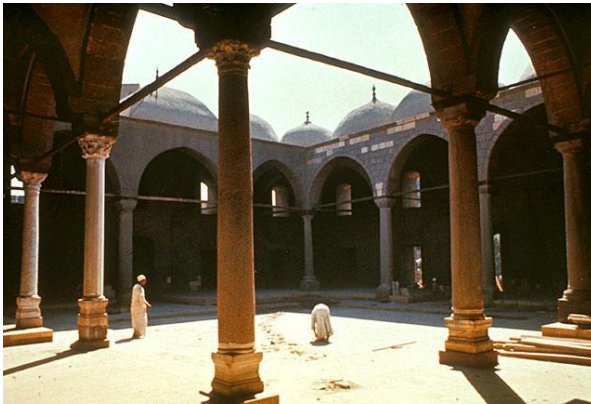
(أ). صورة في السبعينيات قبل الهبوط. (مصدر الصورة:
