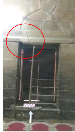
شكل ١٠. شرخ في عتبة شباك (على اليمين) وتم تدعيم العتبة لمنع انهيارها، و شرخ في عتبة باب (على اليسار) وتم ملؤه بمونة جبسية. (تصوير الباحثين).
