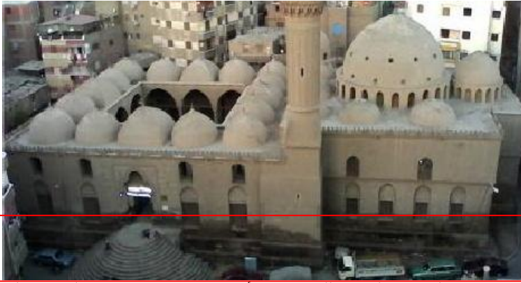
شكل ١٦. الاطار يوضح الدكانة والتشوه اللوني في الأحجار بارتفاع كبير في الواجهة الرئيسية للجامع. (مصدر الصورة: https://commons.wikimedia.org/wiki/File:Melike_Safiye_Camii_2.jpg )
