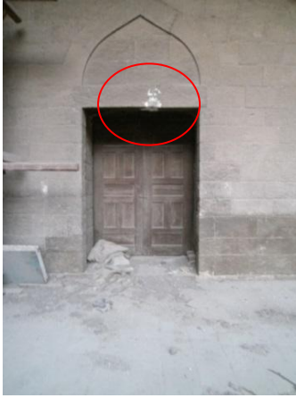
شكل ١٠. شرخ في عتبة شباك (على اليمين) وتم تدعيم العتبة لمنع انهيارها، و شرخ في عتبة باب (على اليسار) وتم ملؤه بمونة جبسية. (تصوير الباحثين).
