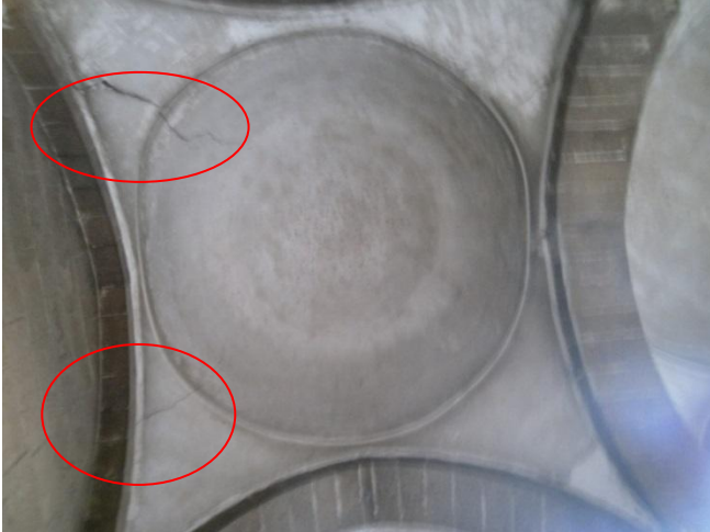
شكل ١٢. شروخ قطرية واسعة ومتوسطة وضيقة في مناطق انتقال أحد القباب التي تغطي صحن الصلاة. (تصوير الباحثين).
