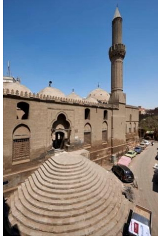
(٢) الواجهة الجنوبية الغربية والمئذنة. (مصدر الصورة: http://archnet.org/sites/2320/media_content )
