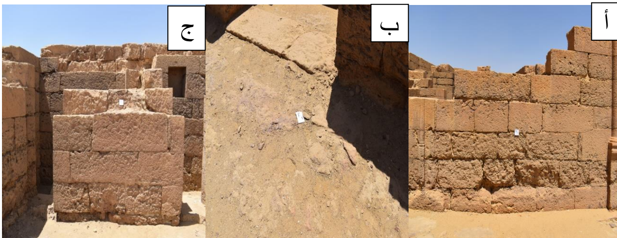
(شكل ٨) يوضح أماكن العينات، حيث أن (أ) مكان أخذ عينة من الجدران من الفناء الأول، و(ب) مكان أخذ عينة من أرضية المعبد من الفناء الأول، بينما (ج) مكان أخذ عينة المونة من المساحة المكشوفة. © عمل الباحثة.
