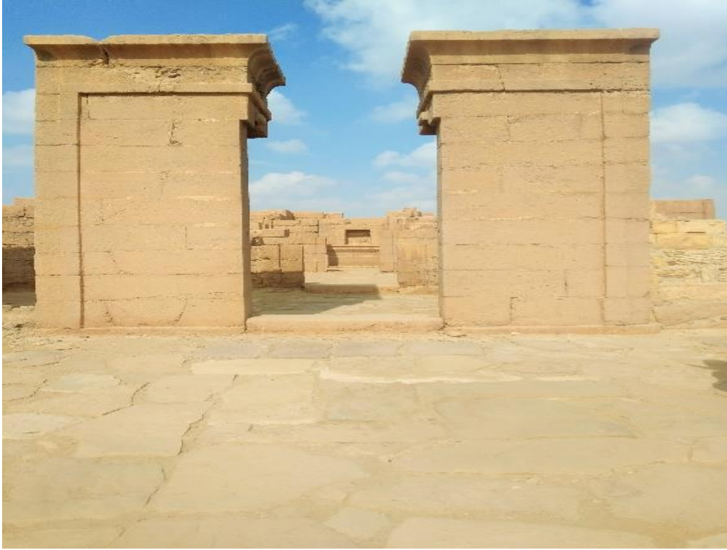
(شكل ٢١) ترميم أرضية المعبد بإجزاء غير متساوية الشكل © تصوير الباحثة.
