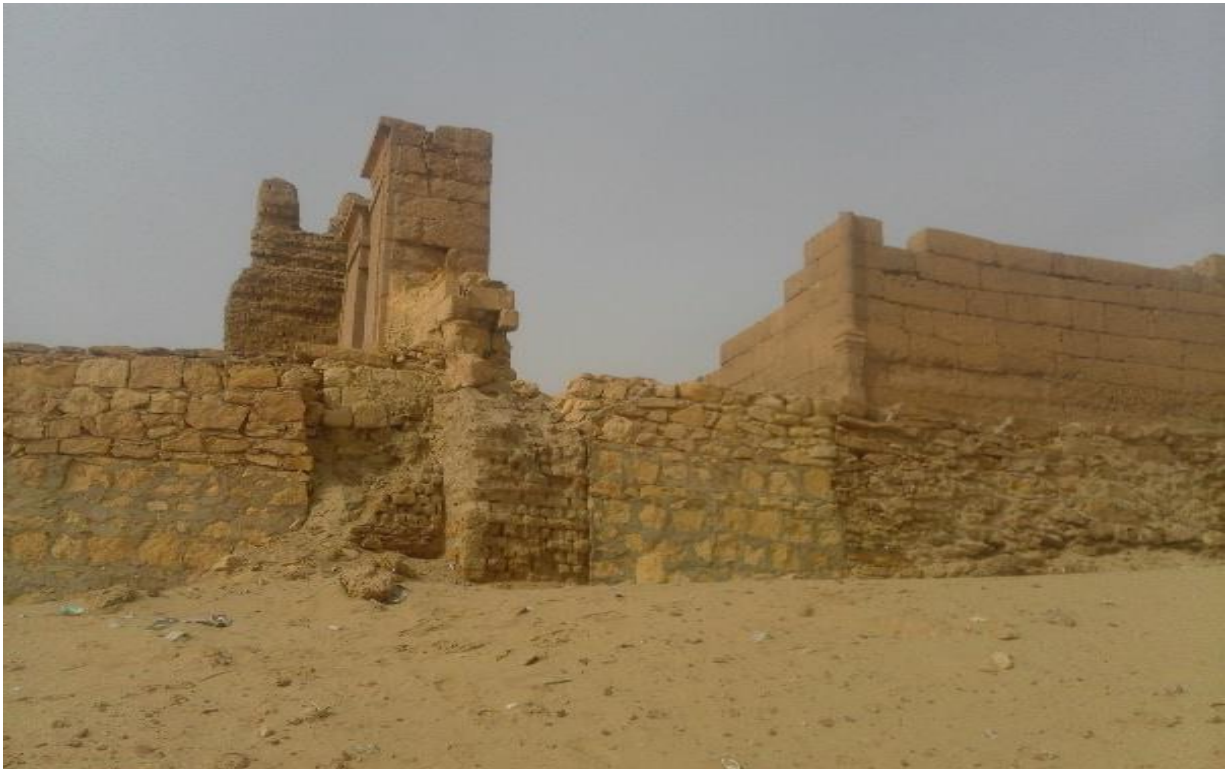
(شكل ٢٢) الترميم السابق بإستخدام مونة الأسمنت كما يوضح تغطية الرمال للأجزاء السفلية من الجدران © تصوير الباحثة.
