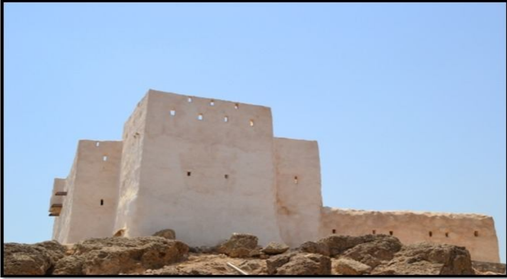
شكل رقم (٦) القلعة العثمانية - الواجهة الغربية حيث السور في أقصى اليمين ثم الدرج ثم البرج ثم القاعدة الرئيسية وجزء من الواجهة الشمالية حيث السقطة وثلاث ميازيب.
