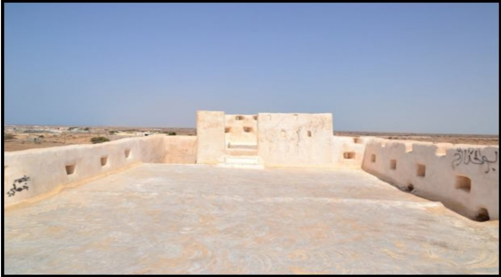
لوحة رقم (١٣) القلعة العثمانية - السطح،الجهة الشمالية بأقصى اليمين،الواجهة الغربية ويبرز في وسطها سور الطابق الثاني من البرج في منتصف اللوحة، الواجهة الجنوبية بأقصى اليسار.
