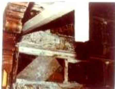
تهالك وأنهيار براطيم السقف
