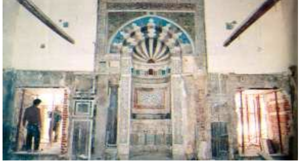
أ- تهالك تام فقد العمود الأيسر إزالة أجزاء كثيرة من الرخام الإتساخ التام فصل المحراب عن الحائط بحوالى ٣٠ سم خروج
