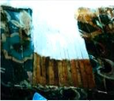
استكمال الأخشاب الناقصة بنفس النوعيات وإجراء عمليات الترميم بنفس مواصفات ولون القبة السابقة
