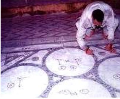
أ- صورة للأرضية أثناء الترميم
