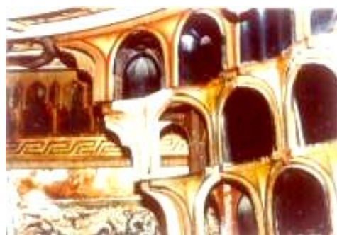
مقرنصات القبّة المذهب وعدم وجود الزجاج وتهالك وفقد في الأخشاب
