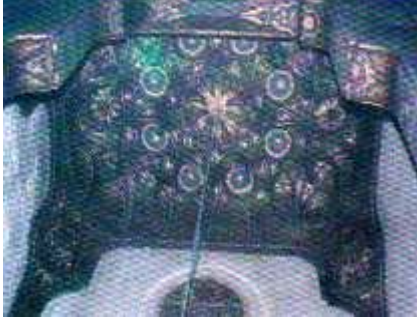
سقف الجزء الأيمن بعد الترميم
