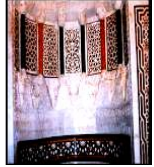
أ- الكتل الرخامية المحفورة بعد الترميم ب- الجزء العلوى للمحراب بعد الترميم والتقوية ج- الرخام المعشق بعد الترميم (سيفساء)
