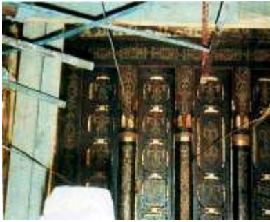
السقف أثناء الترميم
