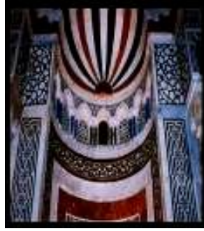
أ- الكتل الرخامية المحفورة بعد الترميم ب- الجزء العلوى للمحراب بعد الترميم والتقوية ج- الرخام المعشق بعد الترميم (سيفساء)
