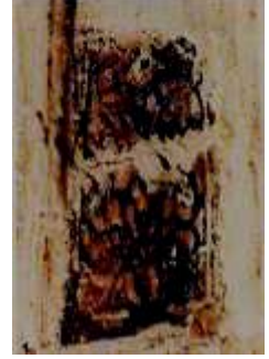
مقرنصات سقف الجزء الأيمن من رواق القبلة ويلاحظ تهاكها الشديد وتحمل الأخشاب وطمس الملونات
