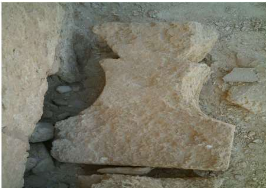
صورة رقم (13) توضح بشكل إحدى الشرافات التي كانت تنوج أعلى واجهات جامع قلعة صدر (الجندي) تصوير الباحث
