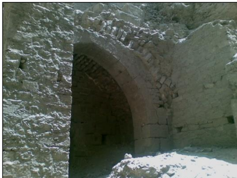
( لوحة رقم ١٥ ) عقود وأقبية ودعامات بالطابق الثاني
