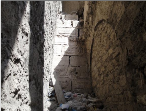
(لوحة رقم ٢٦) فتحة باب السبع قاعات من جهة منطقة باب العزب والذي سد في ترميم الستينات من القرن العشرين
