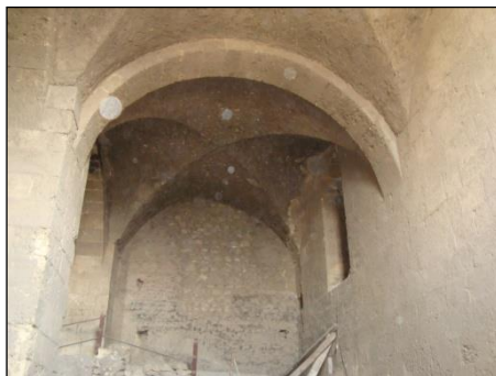
( لوحة رقم ٢١ ) أقبية متقاطعة بقاعات الدور الثاني وتسديد حديث لإحدى الفتحات
