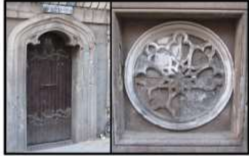
لوحة رقم (٩) مدخل وحلية زخرفية بفيلا فيرناند بحي الشرق بمدينة بورسعيد (تصوير الباحث)
