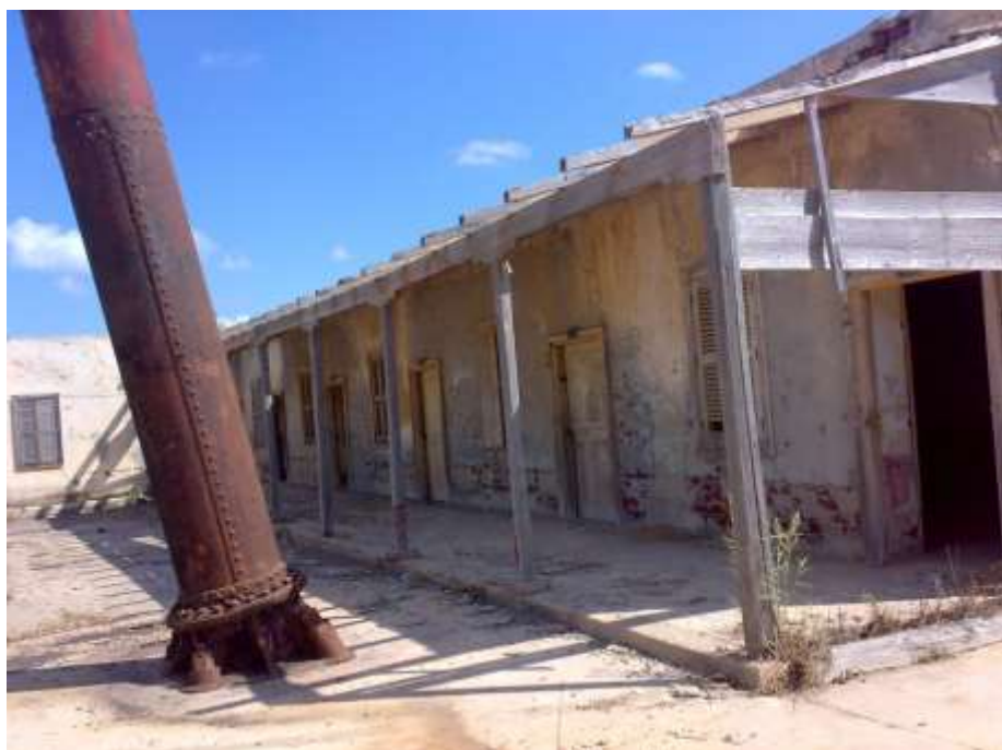
لوحة (١٥) الملحق الجنوبي بفنار البرلس ويظهر به الدعامة الجنوبية لبرج الفنار وطريقة تثبيتها بالأرض
