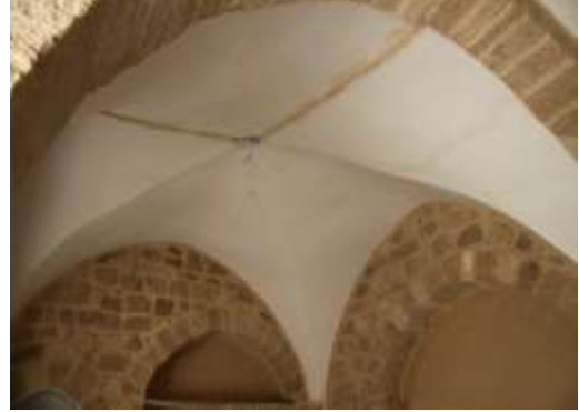
(لوحة ١) صور للأسقف المعقودة من بيت الخضري، حي الزيتون غزة
