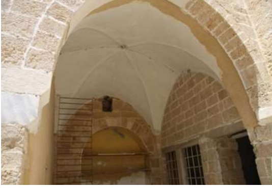
(لوحة ١) صور للأسقف المعقودة من بيت الخضري، حي الزيتون غزة
