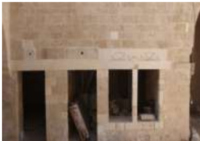
(لوحة ٢٧) الواجهة الجنوبية بيت السقا، حي الشجاعية © تصوير الباحثين
