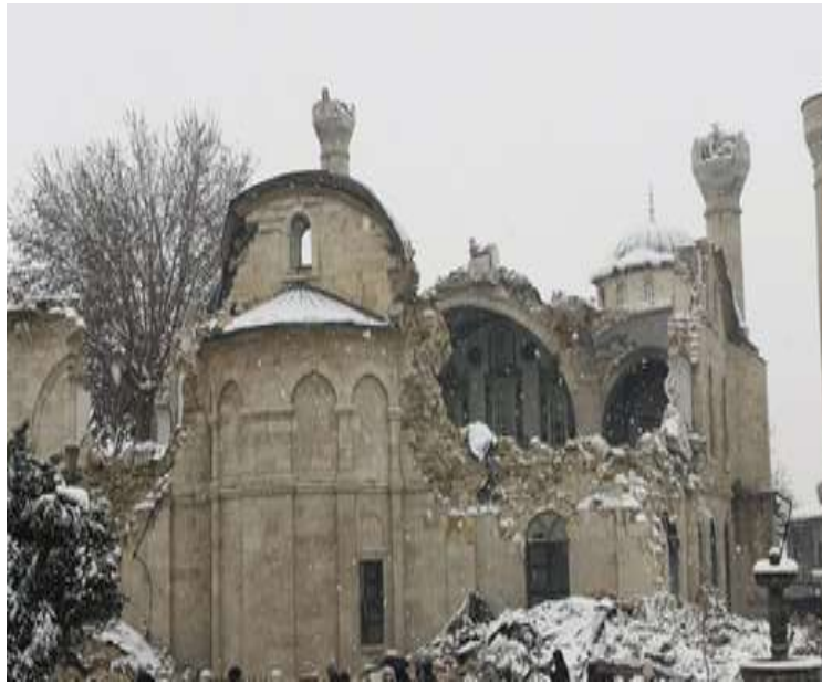
(شكل ١٤) مسجد بنى الكبير قبل وبعد الزلزال توضح انها تقع في منطقة الزلزال التي حدثت بها ارتفاع في منسوب التربة كما هو موضح بالشكل رقم (١٢، ١٣) من صور الأقمار الصناعية الرادارية https://www.9news.com.au/world/before-after-photos-of-turkey-earthquake-devastation/a0c017b1- 82e2-4492-94b4-7b935dd1296d
