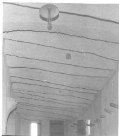
صورة (١٠): سقف قاعة الصلاة الخشبي
