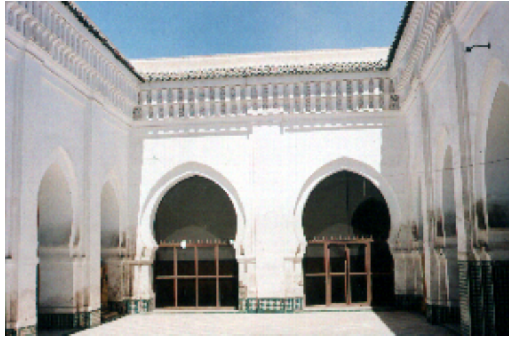
(لوحة ٥) الواجهة الشرقية لصحن جامع ابن صالح المريني بمراكش، تصوير الباحث.
