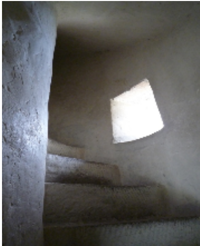
(لوحة ٤٢) الدرج الحلزوني واحدى فتحات الإضاءة والتهويه
