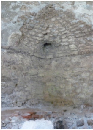
(لوحة ٢٦) إحدى الحنايا الركنية كمنطقة انتقال ويتوسطها الجرة المدفونة
