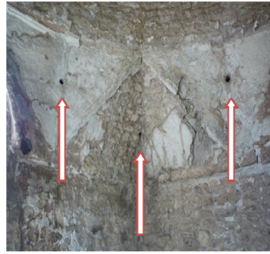
(لوحة ٢٥) مناطق الإنتقال الداخلية في الضريح ويتوسطها فتحات Acoustic jars
