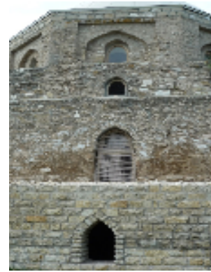
(لوحة ٥١) الواجهة الشمالية للقاعة توضح فتحات النوافذ المعقودة ورقبة القبة
