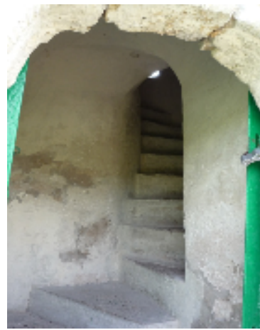
(لوحة ٤١) فتحة باب معقودة تؤدى إلى الدرج الداخلى للمئذنة
