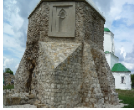
(لوحة ٢١) الزاوية الجنوبية الشرقية من الضريح ومنطقة الإنتقال واحدى المضاہيات بعد الترميم
