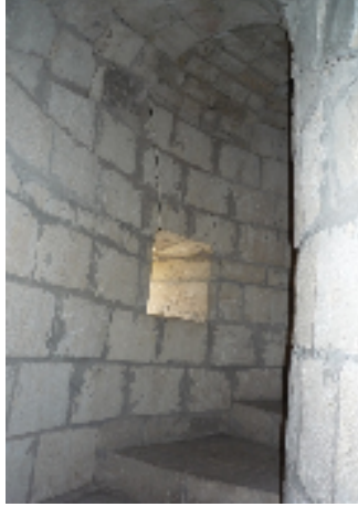
(لوحة ١٣) الجدار الداخلى لبدن المئذنة وفتحة إضاءة وتهوية الدرج
