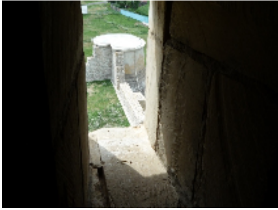
(لوحة ١٥) احدى فتحات إضاءة وتهوية الدرج وتشبه فتحات المزاغل
