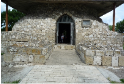
(لوحة ٣٠) واجهة الضريح الشمالية ويتوسطها فتحة المدخل
