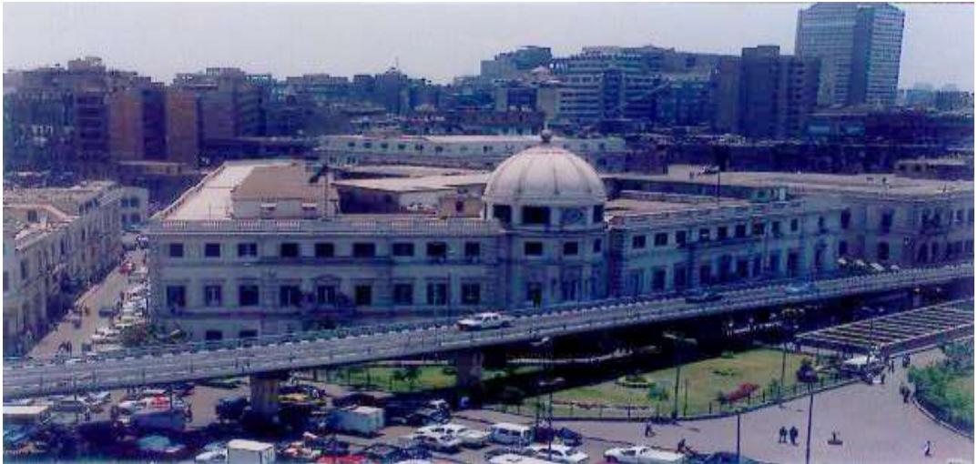
لوحة (٢) منظر عام لمبنى البريد بالعتبة
