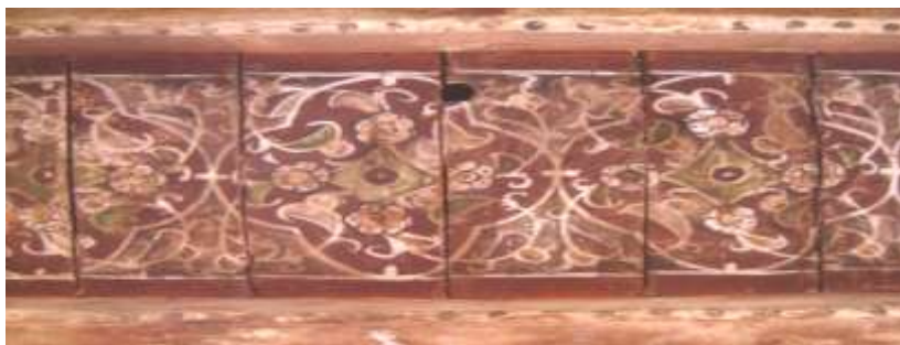
صورة رقم (٢٤) توضح انفصال الألواح الخشبية عن بعضها نتيجة لتفاوت معدل درجات الحرارة والرطوبة النسبية
