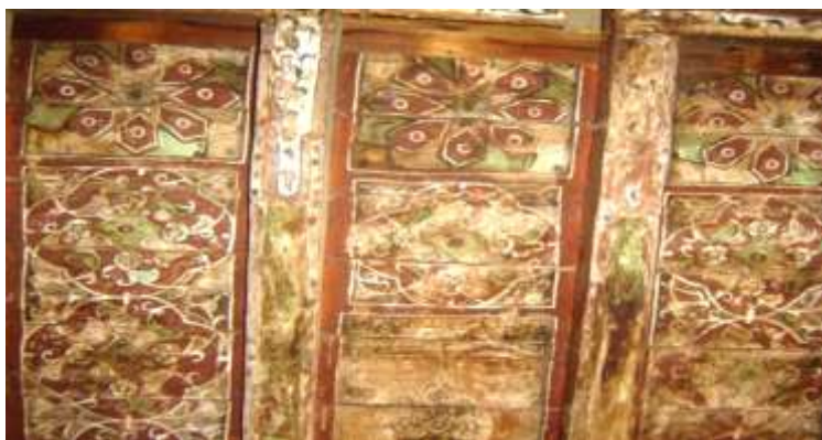
صورة رقم (٢٥) توضح انفصال أجزاء من طبقة التحضير واللون نتيجة لتفاوت معدل انكماش طبقة الرسم والحامل الخشبي بسبب تفاوت معدل درجات الحرارة والرطوبة
