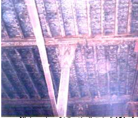
صورة رقم (٢) توضح السقف الخشبي لمسجد الامير حسن بأخميم يحمله اربعة وعشرون عمود يربط تلك الاعمدة أوتار للربط والاتزان
