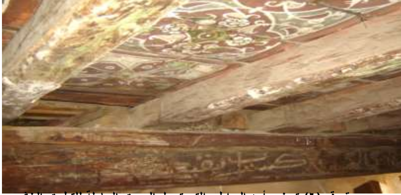
صورة رقم (٦) توضح أحد البراطيم التي تحمل العروق الحاملة للتطبيق الخشبي
