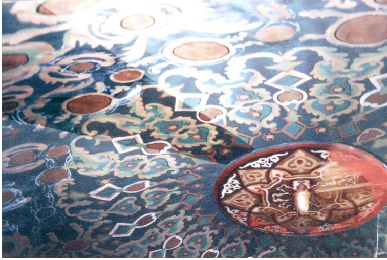
شكل رقم (٢٣) تنظيف ومعالجة الزخارف القديمة وإزالة الأجزاء المدهونة عليها في ترميم حديث
