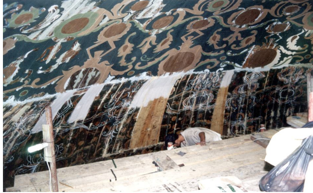
شكل رقم (٢٢) ملئ الفواصل ومعالجة الأخشاب الجديدة وتلوينها طبقا للعناصر الزخرفية الموجودة
