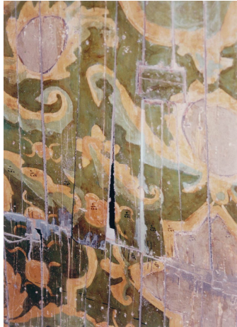
شكل رقم (٤) نلاحظ فقدان أجزاء من أرضيات التحضير والمواد الملونة بالقبة وتهالك الأخشاب
