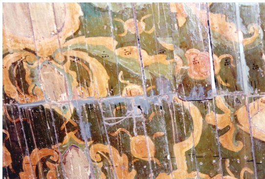
شكل رقم (٥) ظهور شروخ كثيرة بالقبة مع سقوط العناصر الزخرفية نتيجة الترميم الخاطئ
