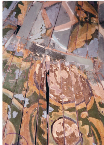
شكل رقم (٣) التدهور في حالة القبة نتيجة الترميم الخاطئ والمواد الراتنجية الصلبة
