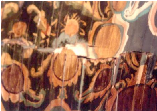
شكل رقم (٧) الترميم الخاطئ للأخشاب ادي إلى بعض العناصر الزخرفية عن بعضها
