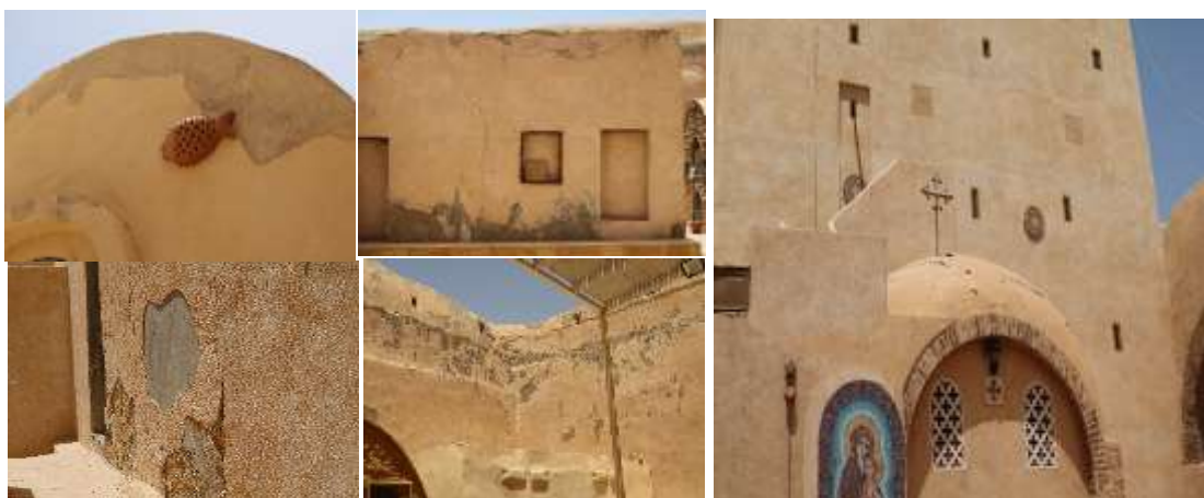
(لوحة ٩) توضح حدوث شروخ وتساقط في طبقات التغطية الخارجية نتيجة إختلاف معدلات التمدد والإنكماش بين مواد البناء © تصوير الباحثين
