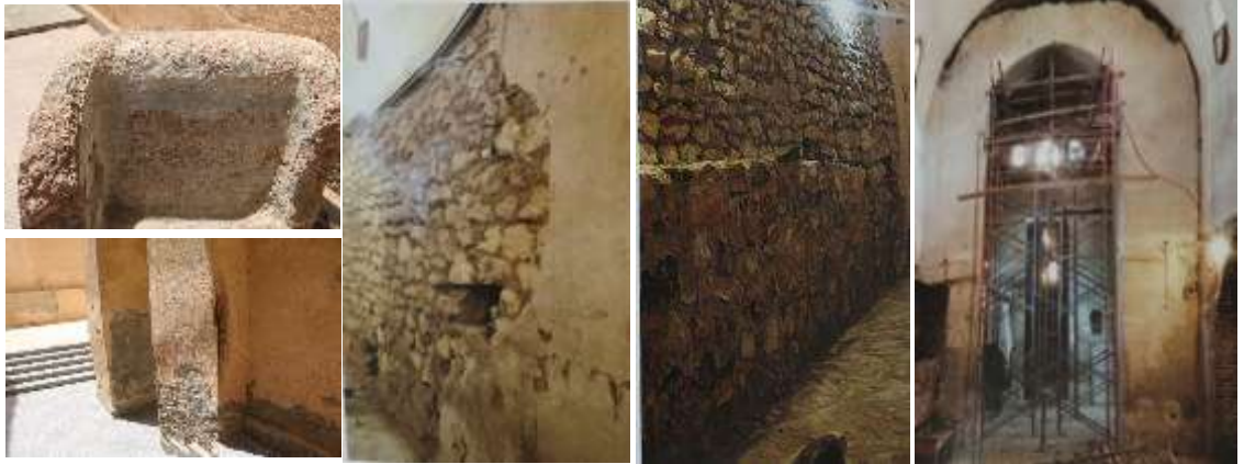
(لوحة ٦) توضيح تساقط طبقات التغطية الخارجية وفقد المواد الرابطة بين الكتل الحجرية ووجود شروخ عميقة بالعقود مما استدعى عمل صلبات لوقف الإنهيار وتزهر الأملاح © تصوير الباحثين
