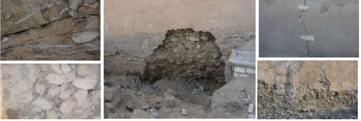
(لوحة ٣) توضح تفكك أحجار السور البحري وتداعى الأجزاء السفلية للتكسية الخارجية بالسور علاوة على وجود الشروخ العميقة نتيجة المشاكل الخاصة بالتربة ©تصوير الباحثين.
