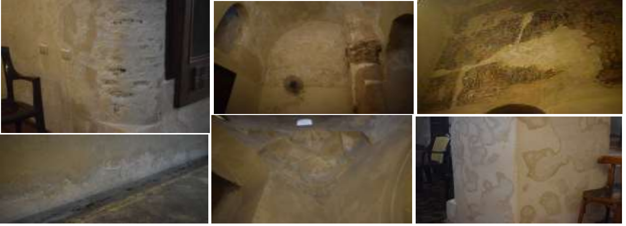
(لوحة ٤) توضح تزهير الأملاح سواء في الأسقف والجزء السفلى للجدران وعلى الجدران نفسها والصور الجدارية ©تصوير الباحثين
