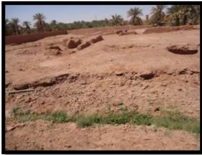
(لوحة ١٠) ارتفاع منسوب المياه ونمو الحشائش بسبب ارتفاع الرطوبة ©عمل الباحث
